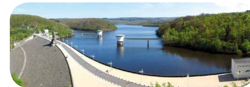
Le barrage de Gileppe, situé dans les Hautes-Fagnes, fut construit dès 1867 pour répondre aux besoins de l'industrie belge. Il possède actuellement une capacité de 26,4 millions de mètres cubes d'eau.
